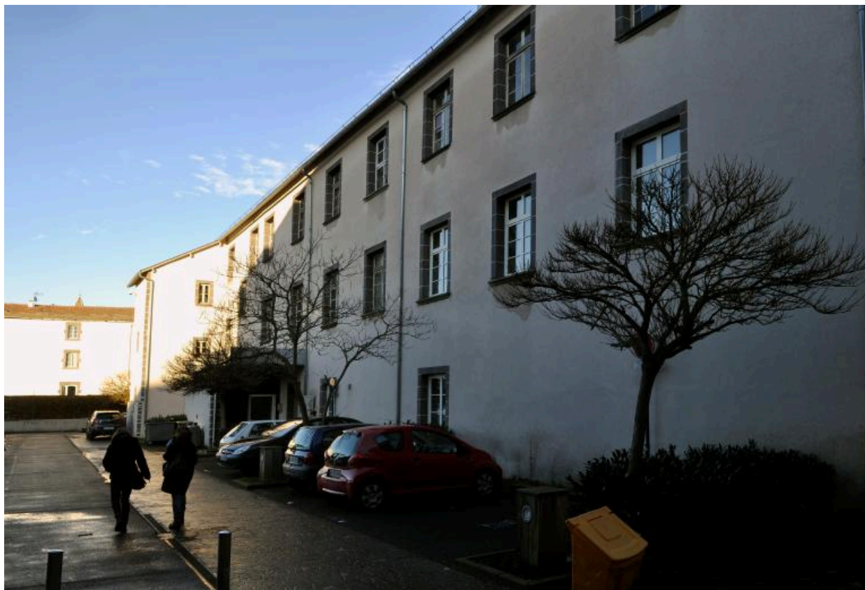
Corps de bâtiment ouest : élévation postérieure, depuis le sud
