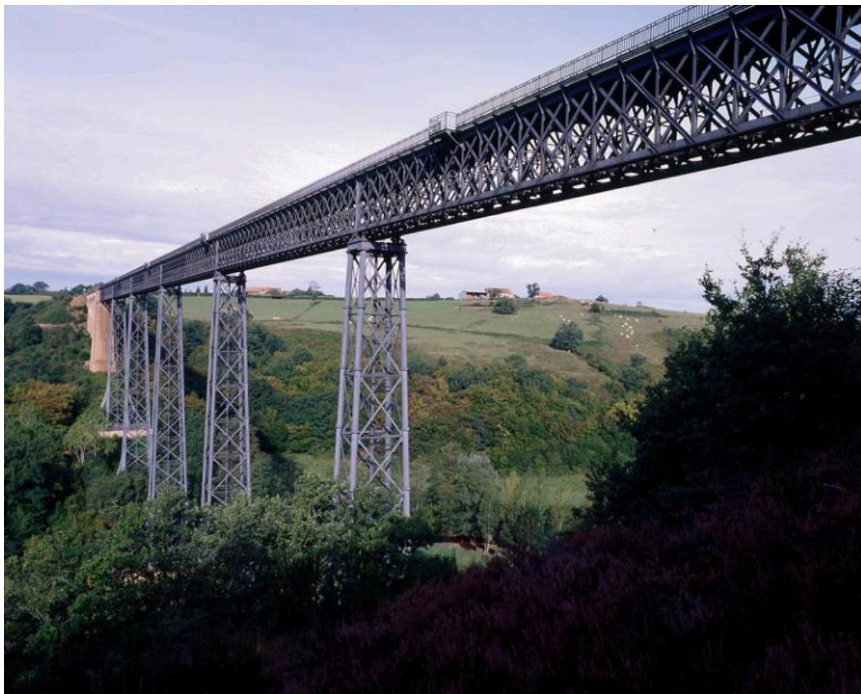
Vue générale de trois quarts du viaduc dans le site.
