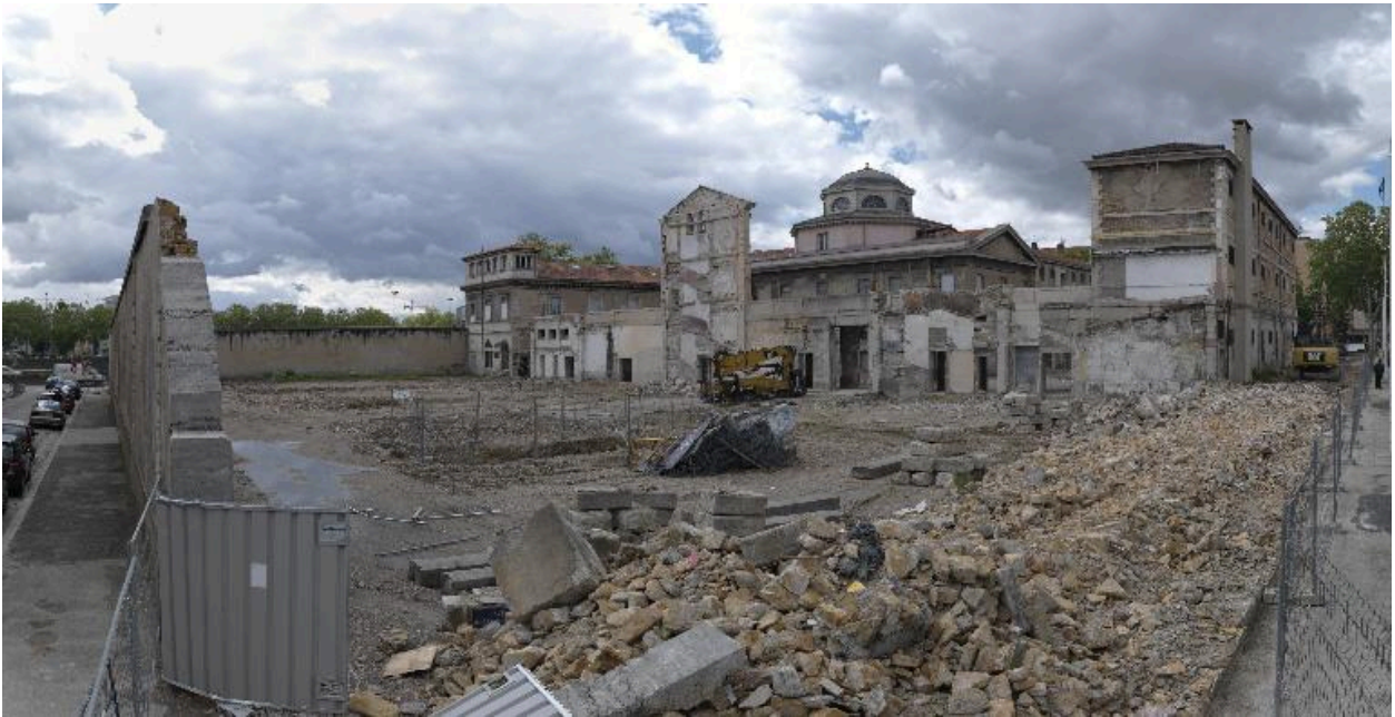
Etat en juin 2013 : vue générale depuis le nord-ouest
