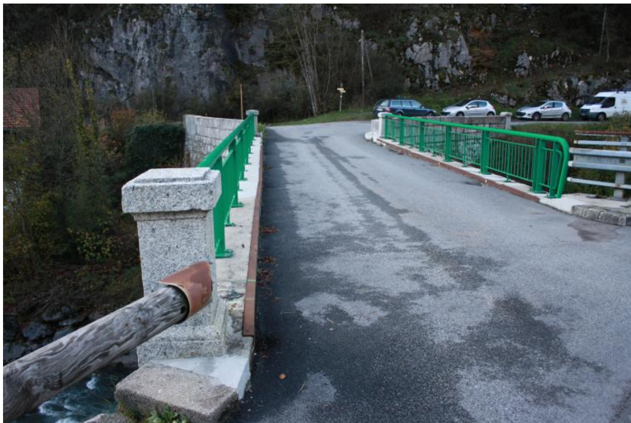
Ancien pont de Gys, chaussée et gardes corps
