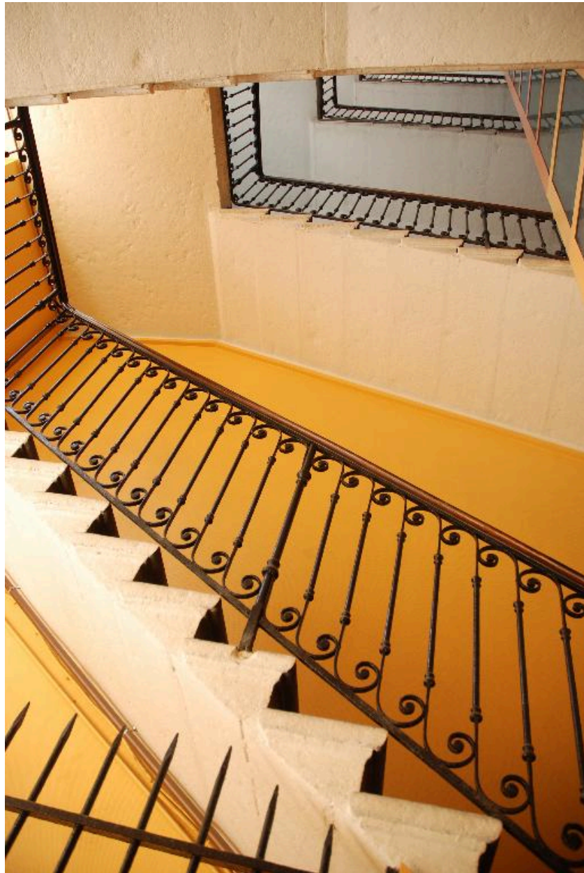
Immeuble sud : escalier, vue en contre-plongée
