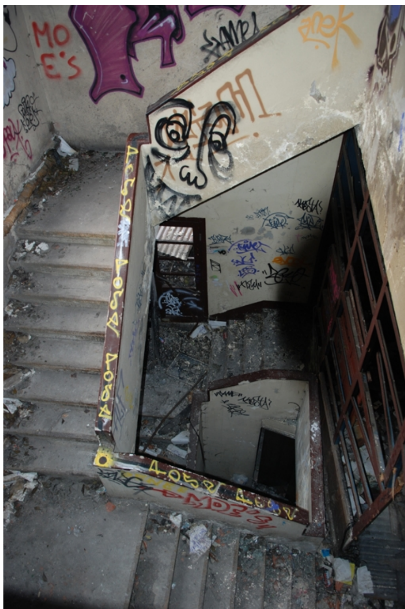
Vue d'ensemble escalier
