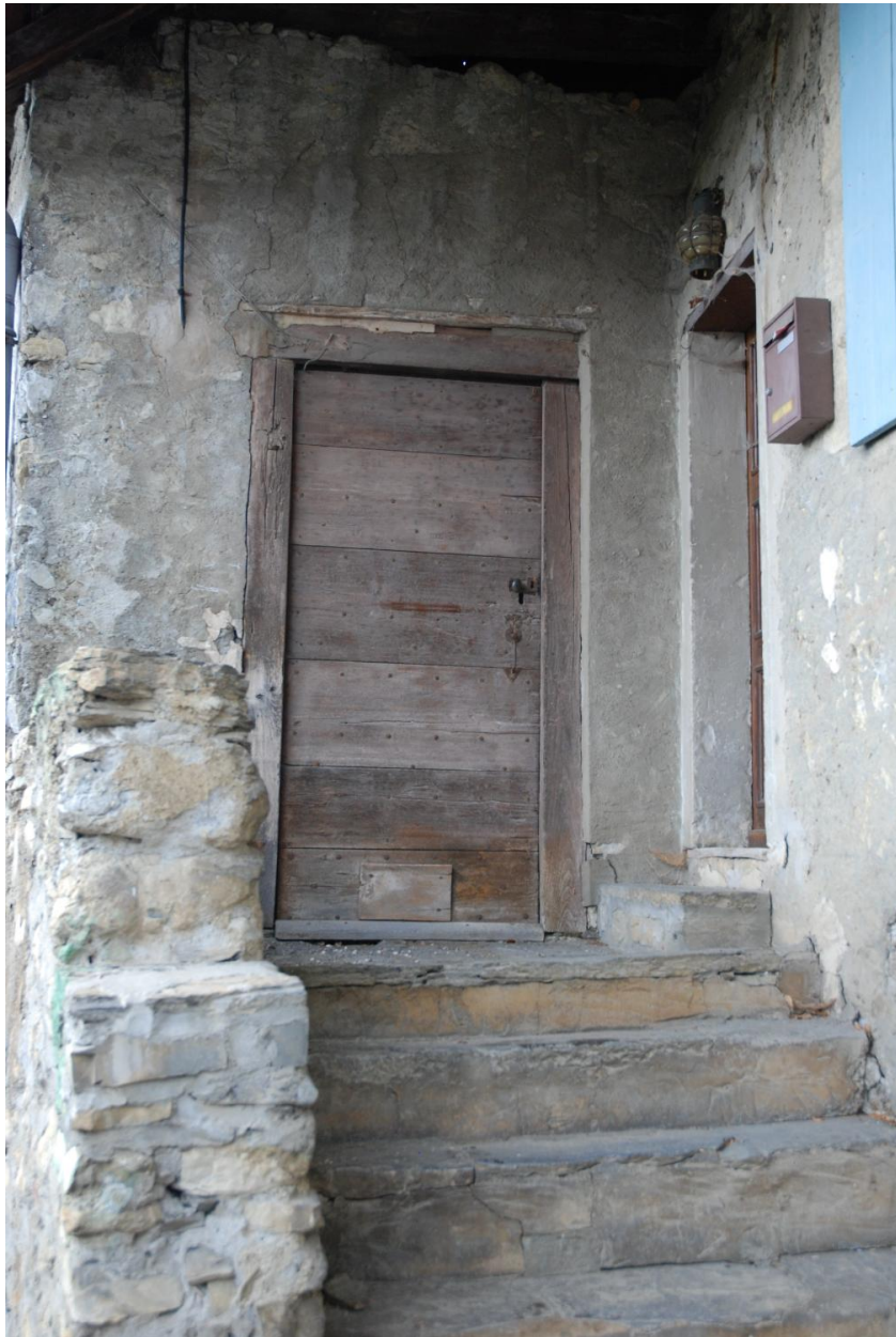
Cellier viticole, dit sarto (2018 E3 1707 et 955). Détail de l'escalier et des portes d'habitation.
