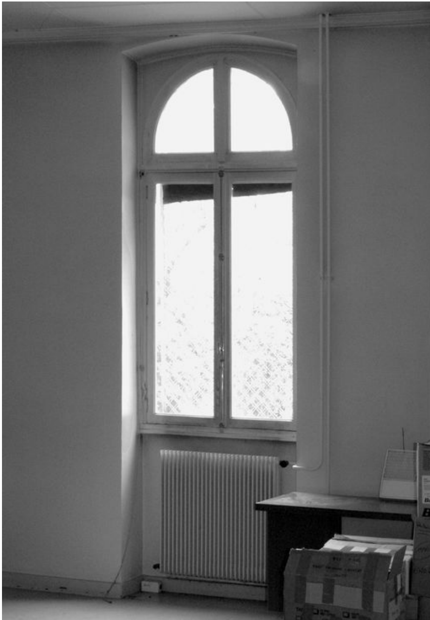
Rez-de-chaussée, aile est, détail d'une fenêtre
