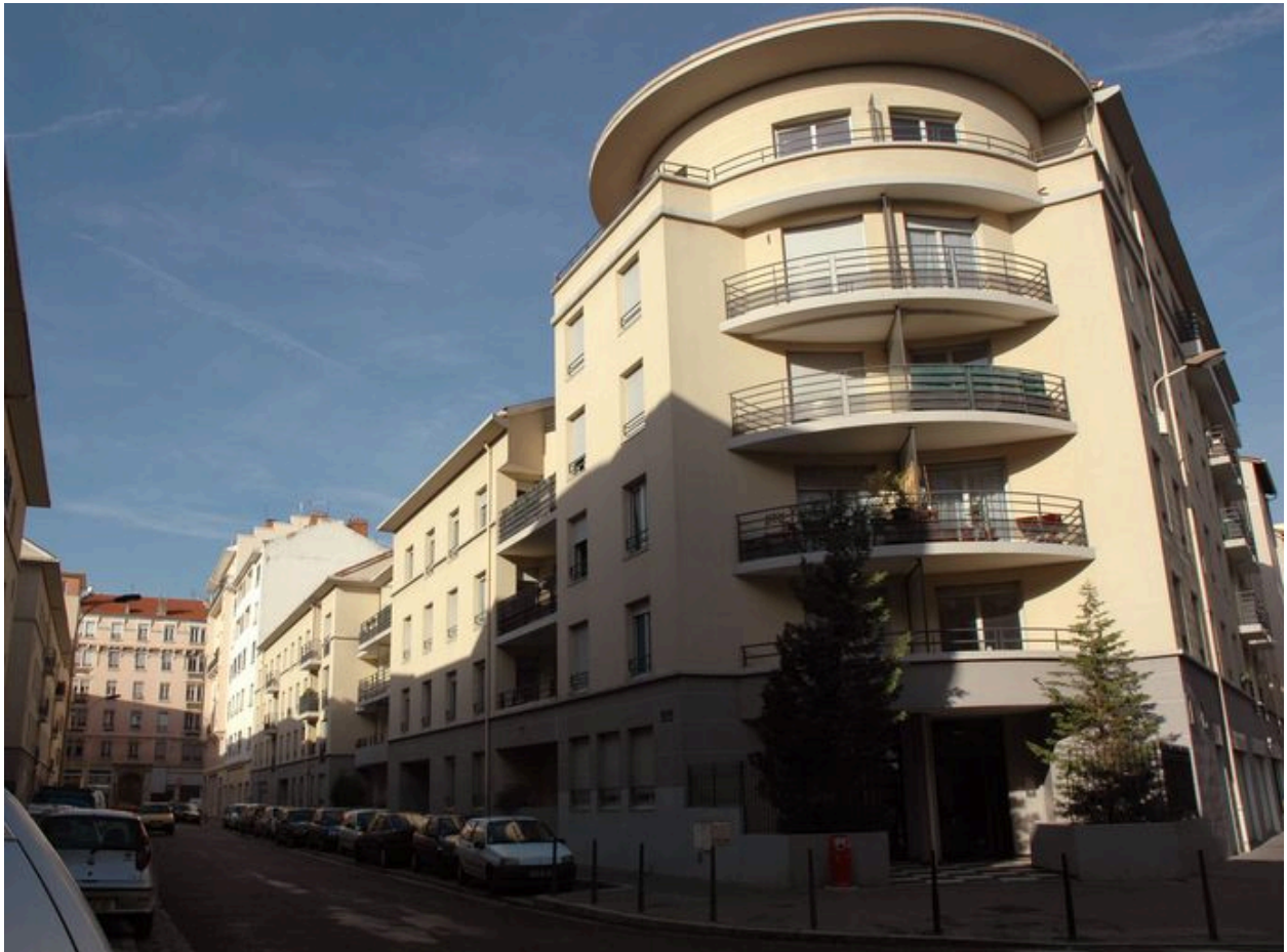
Vue d'ensemble vers l'ouest, rue Alphonse-Daudet
