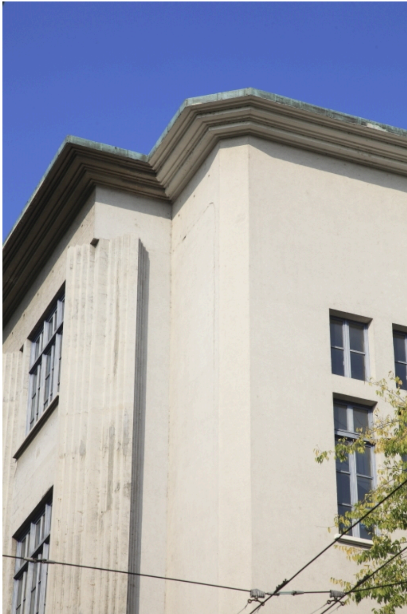
Le bâtiment principal. Détail de l'attique.
