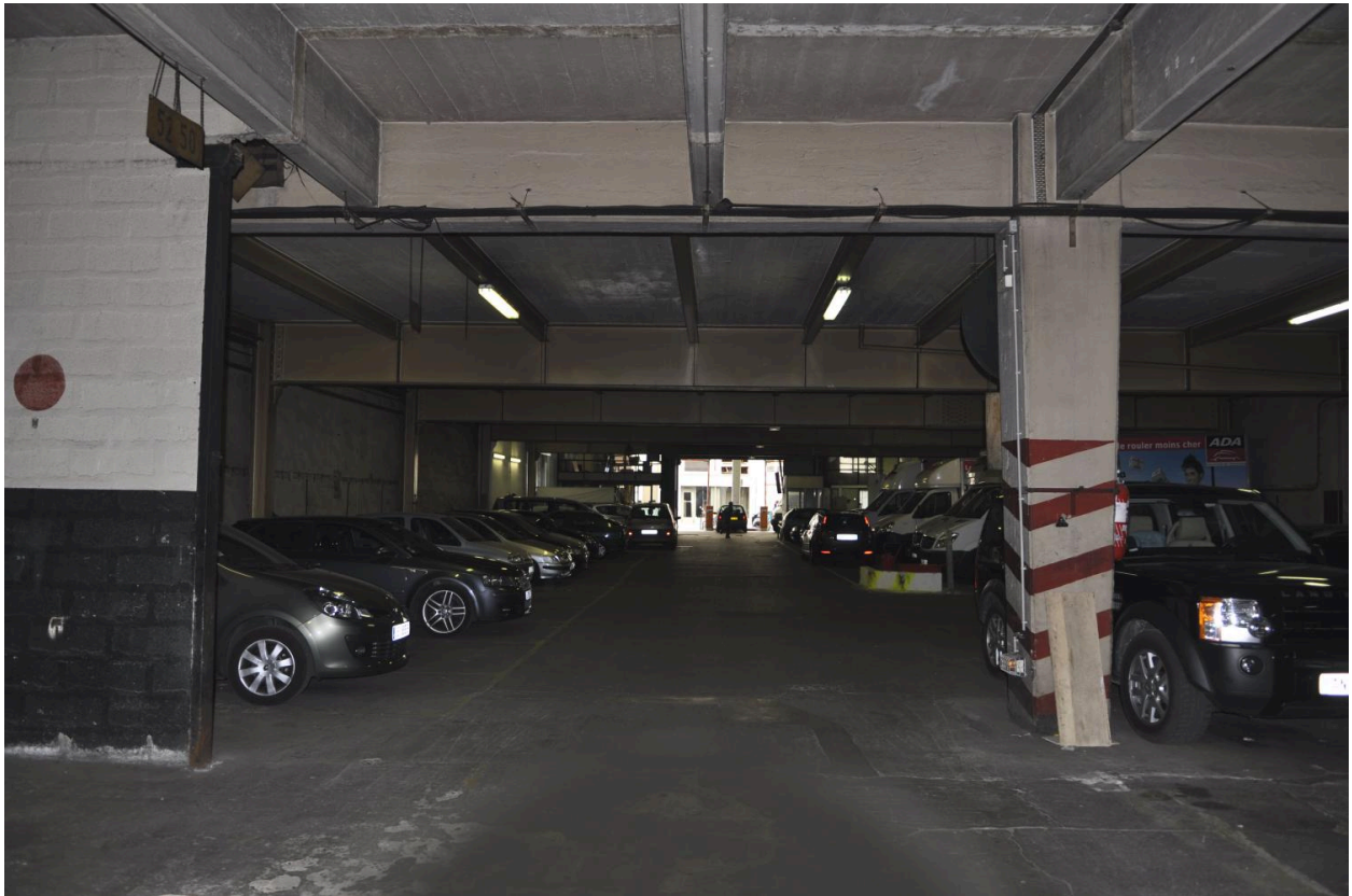
Vue intérieure du parking souterrain
