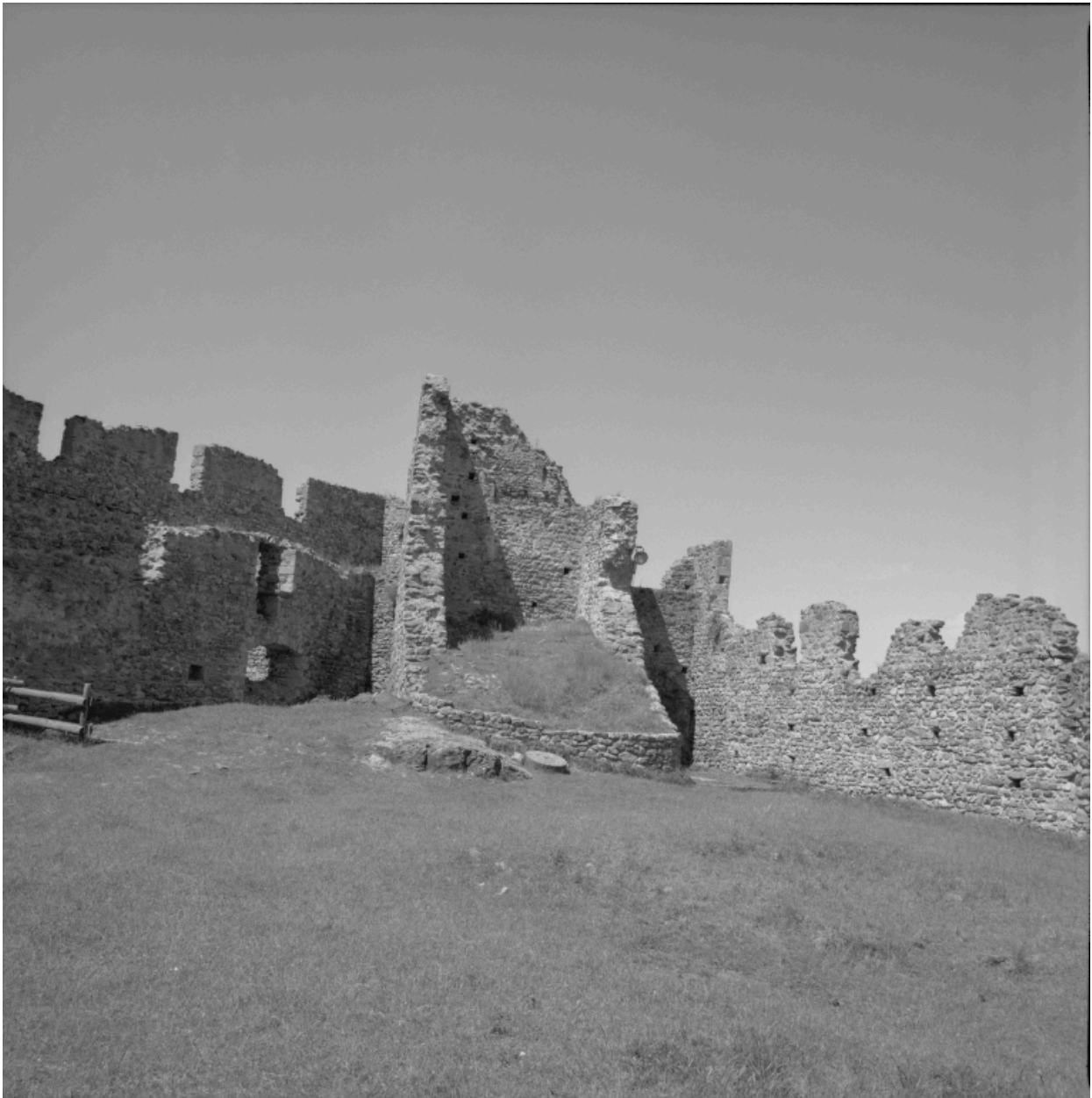
Château-fort primitif : vue intérieure de la tour carrée dite tour des Dames ou Damas, du sud.
