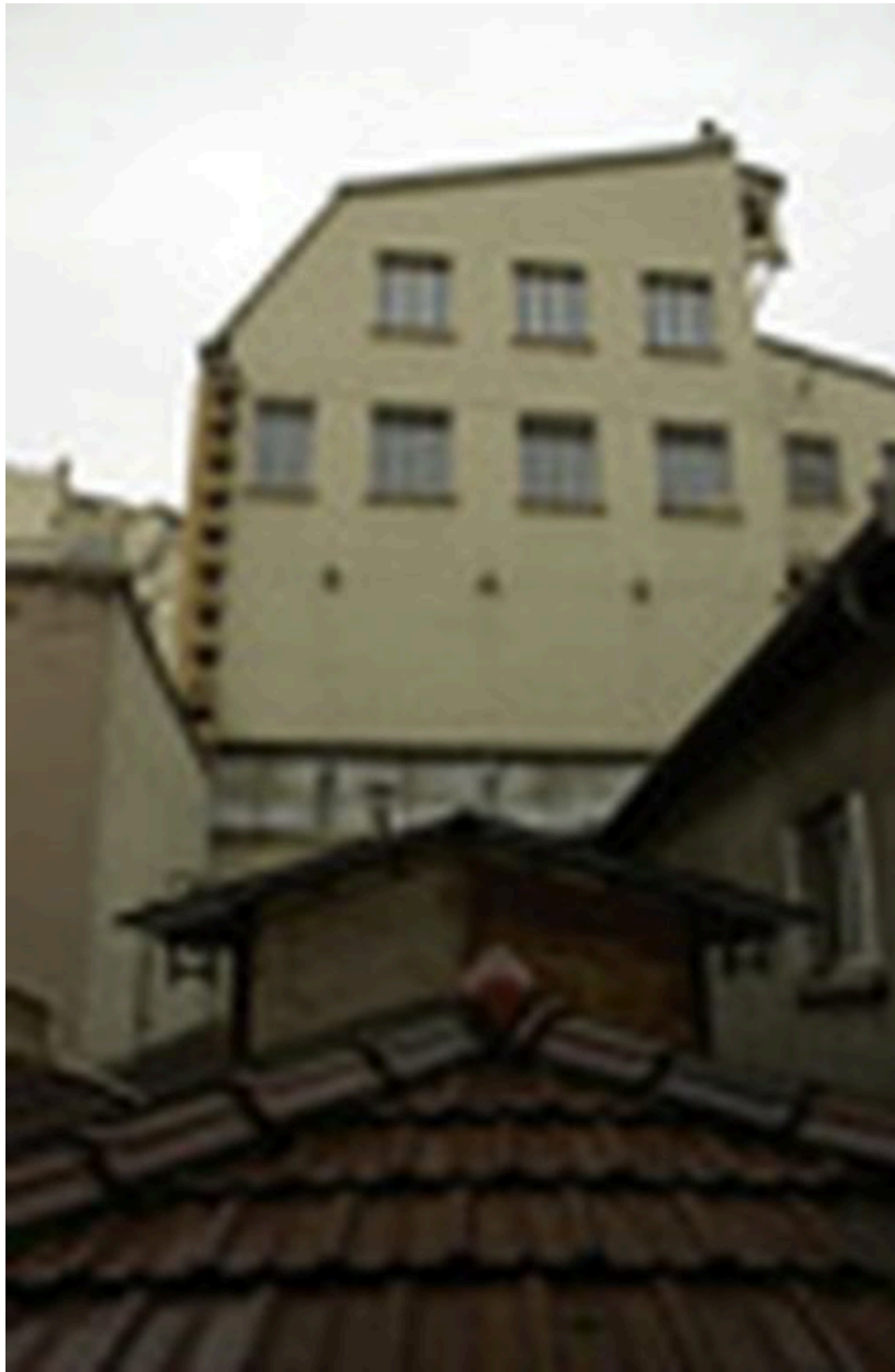
Vue du lanterneau du garage depuis le 3 rue de Savoie
