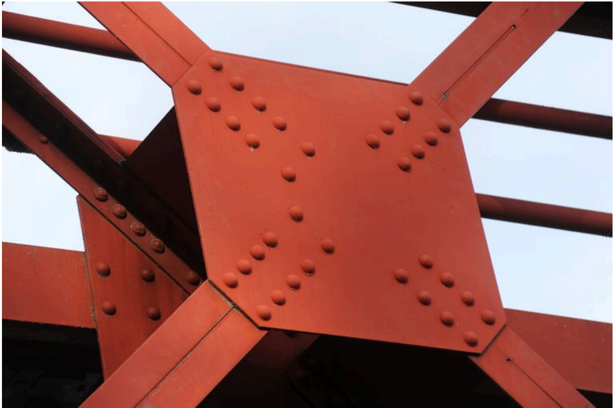
Parapet, vue partielle : assemblage (depuis la rive droite)
