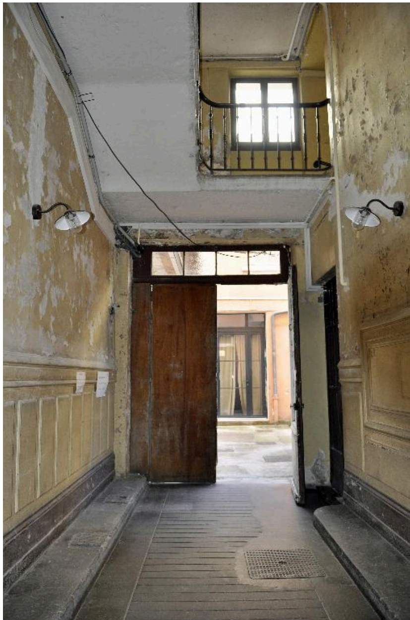
Immeuble sur rue, vue intérieure : le passage cocher et l'escalier
