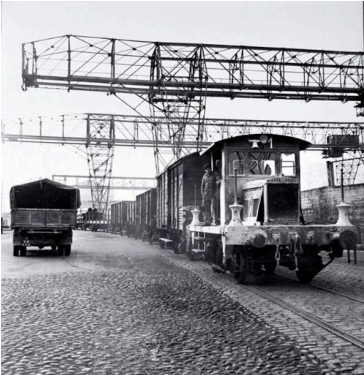
Le port Rambaud en 1952. Train et camion passant sous les ponts-portique. photographie, 1952 Chambre de commerce et d'industrie de Lyon. S1 T1 5 n° 2
