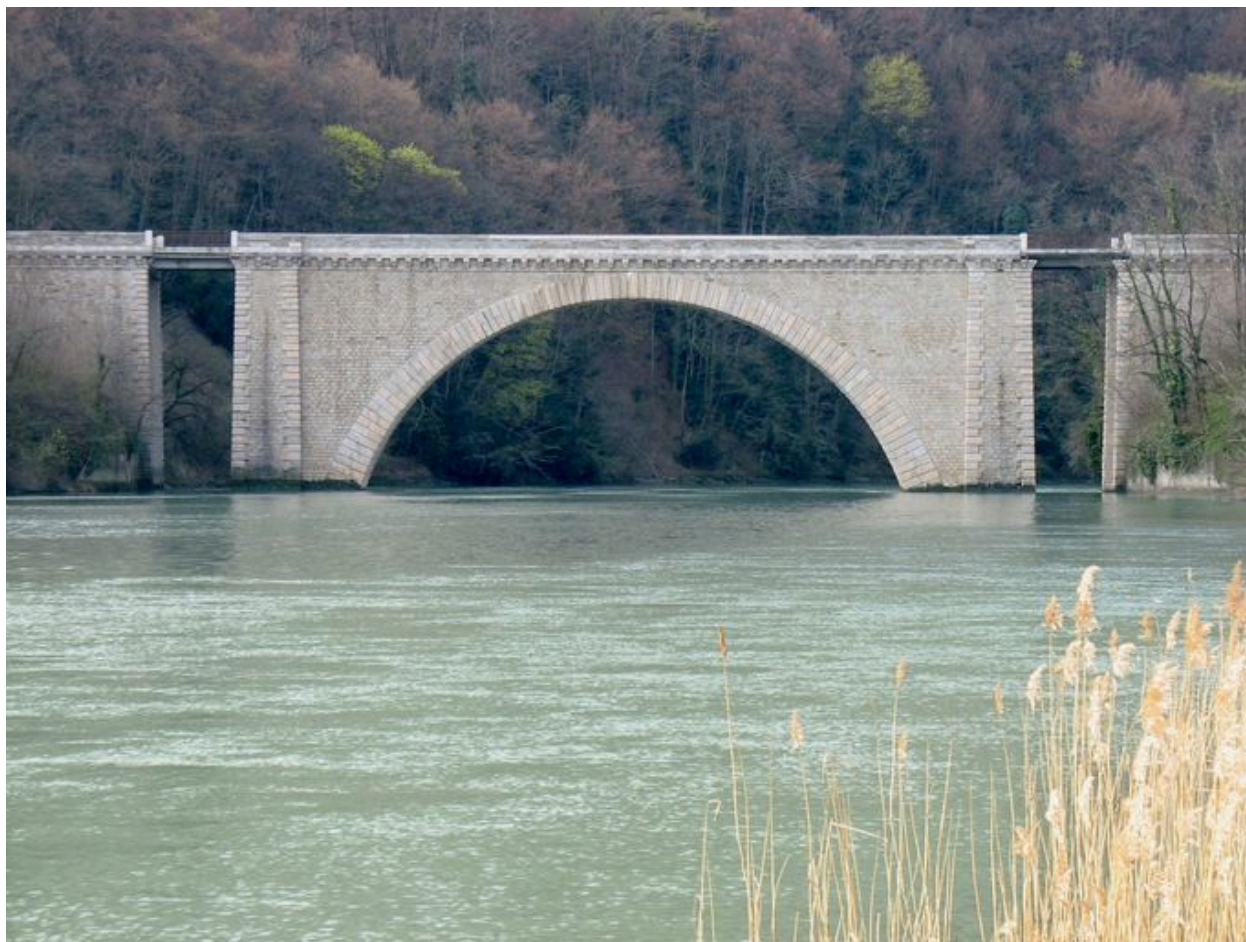
Vue générale, côté amont
