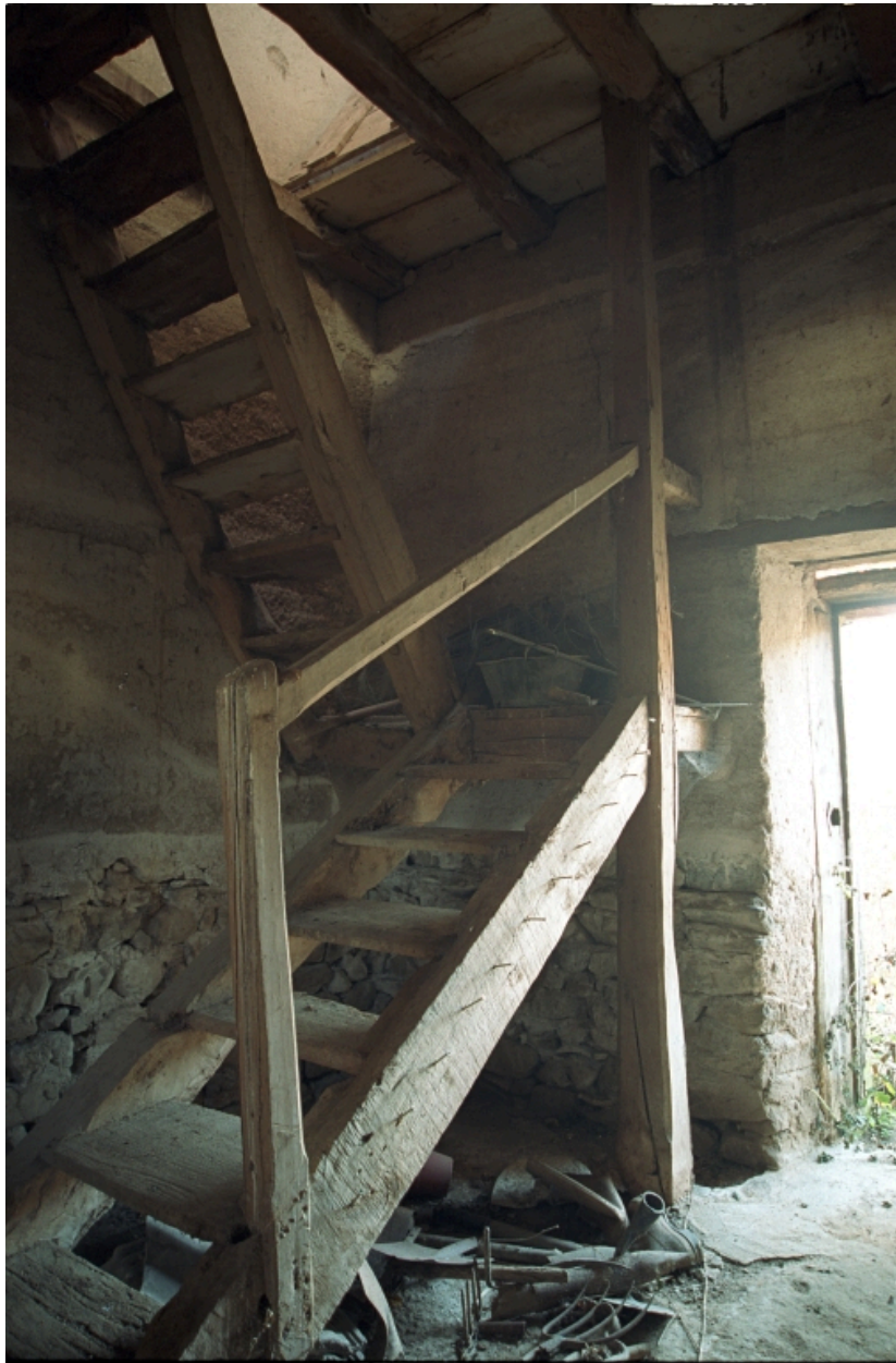
Vue intérieure du rez-de-chaussée.
