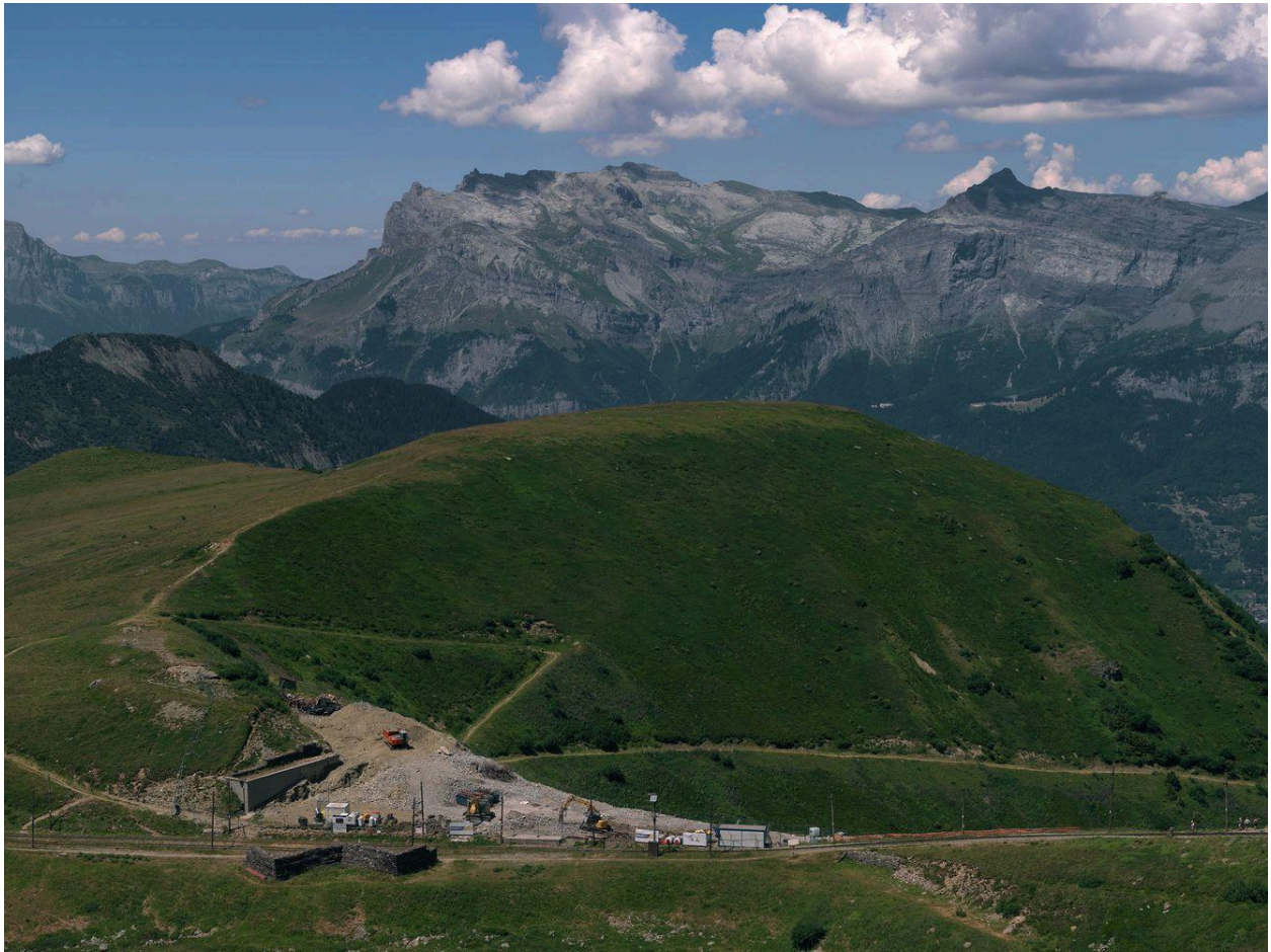
Vue d'ensemble de la plateforme
