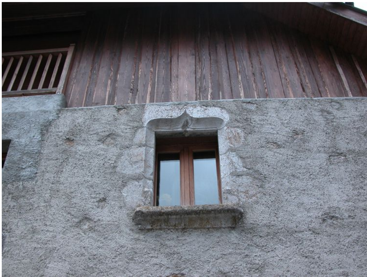
Fenêtre à accolade sur mur est.
