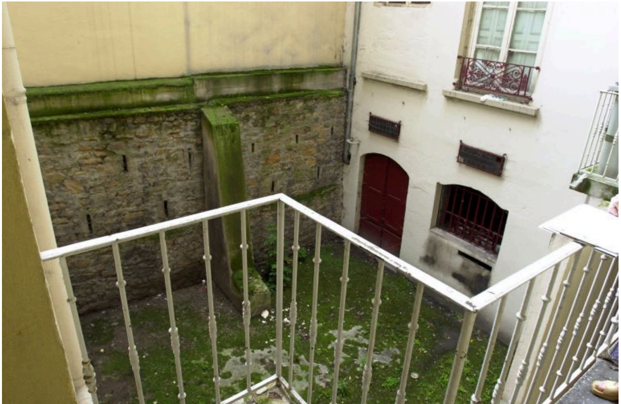
Vue de la cour en contrebas
