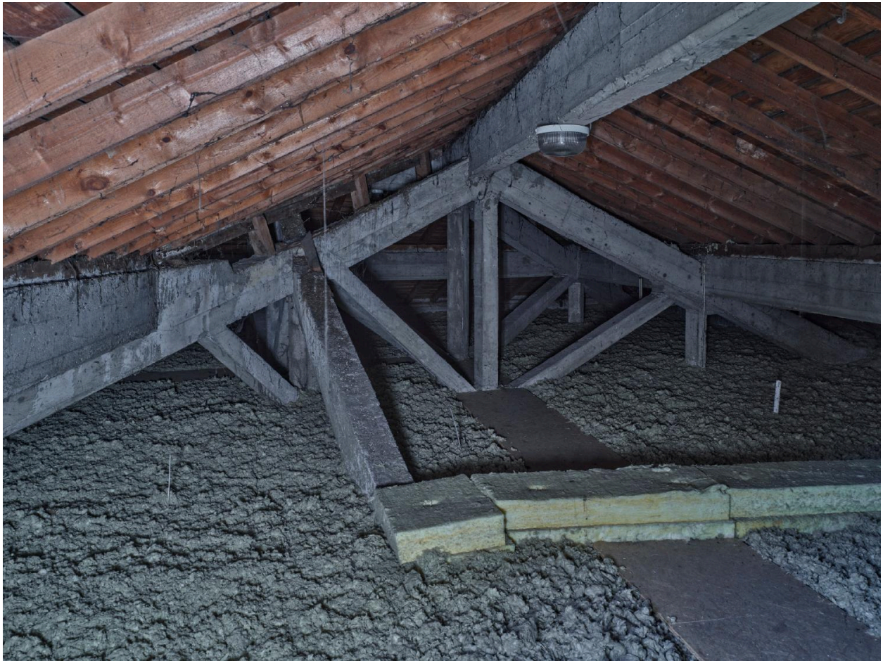
Charpente de toit en "béton de ciment armé", couvrant le bâtiment principal. (L'aile de l'internat est couverte d'une charpente en sapin.)
