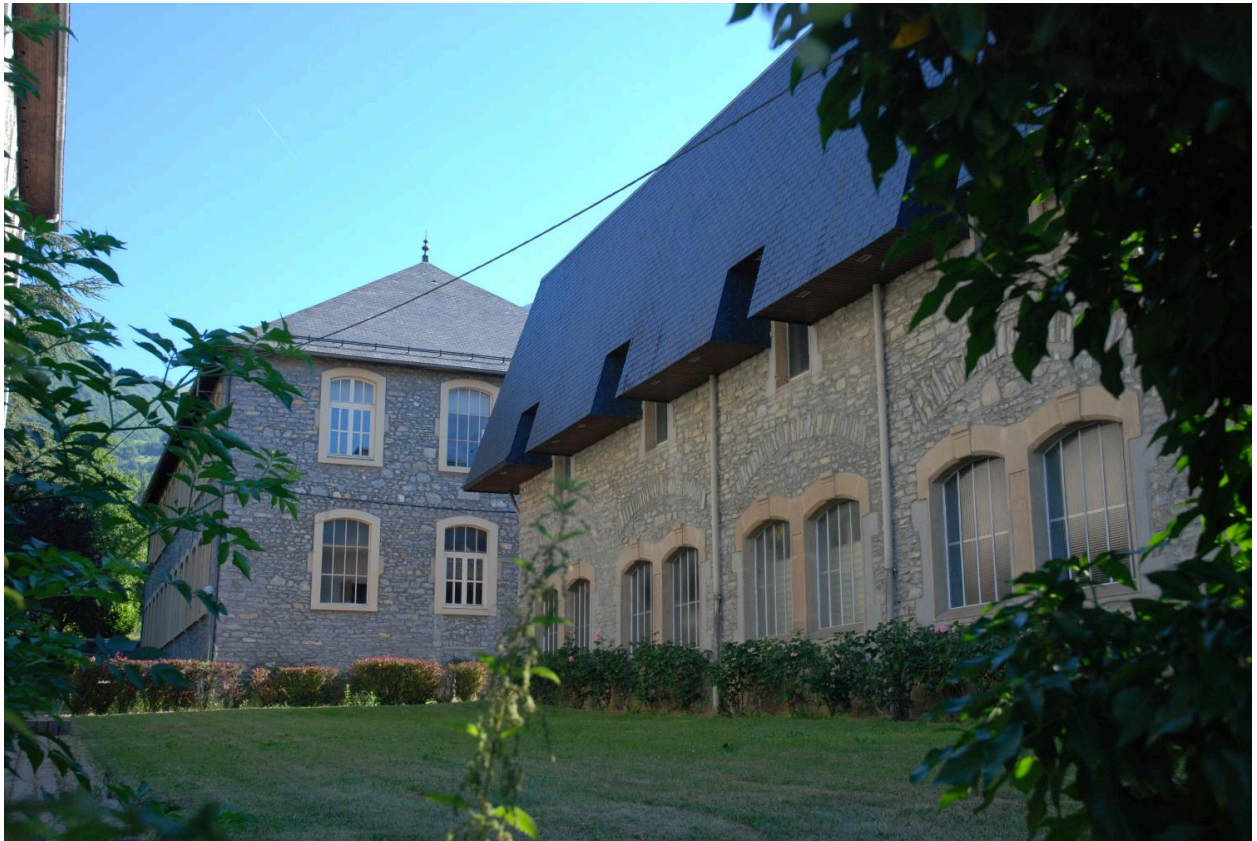
Vue extérieure, bâtiments sud.
