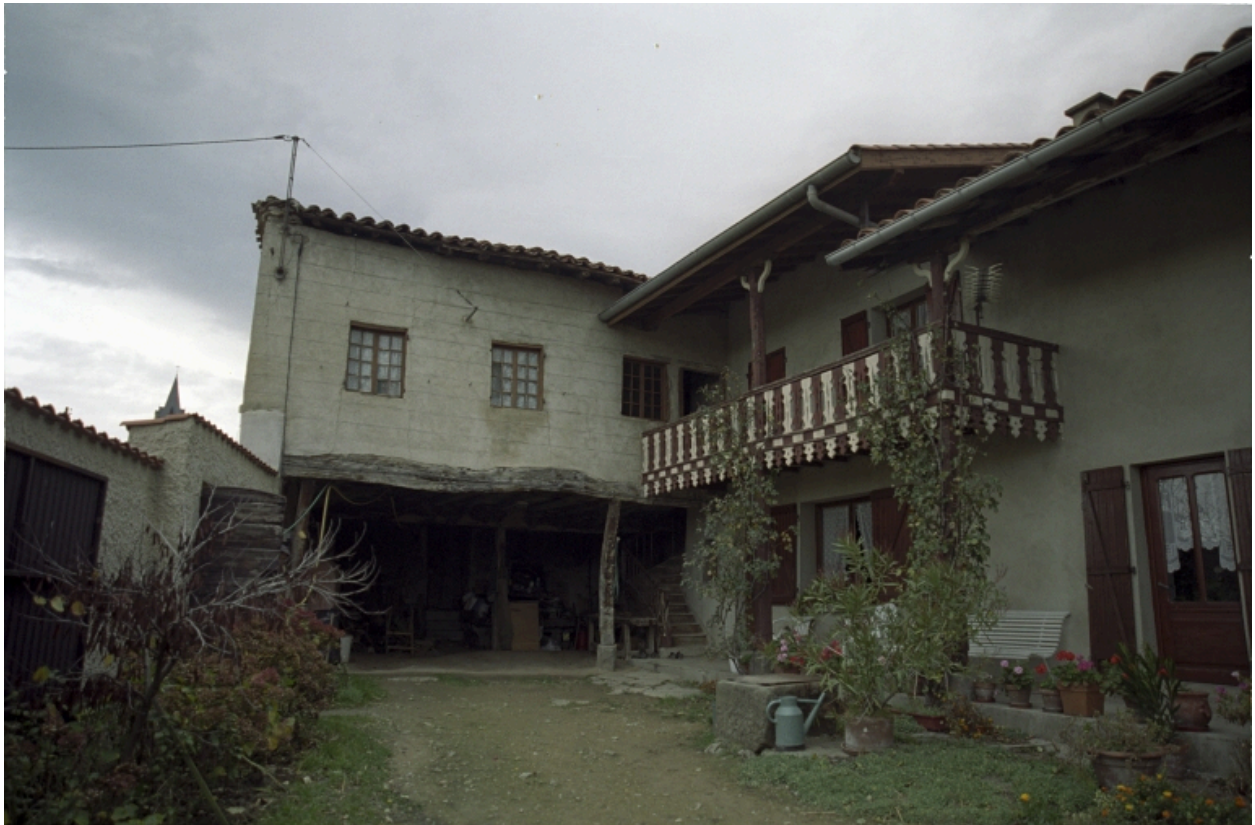
Saint-Sixte, la treille (1987 A1 46). Vue d'ensemble de la ferme depuis la cour.
