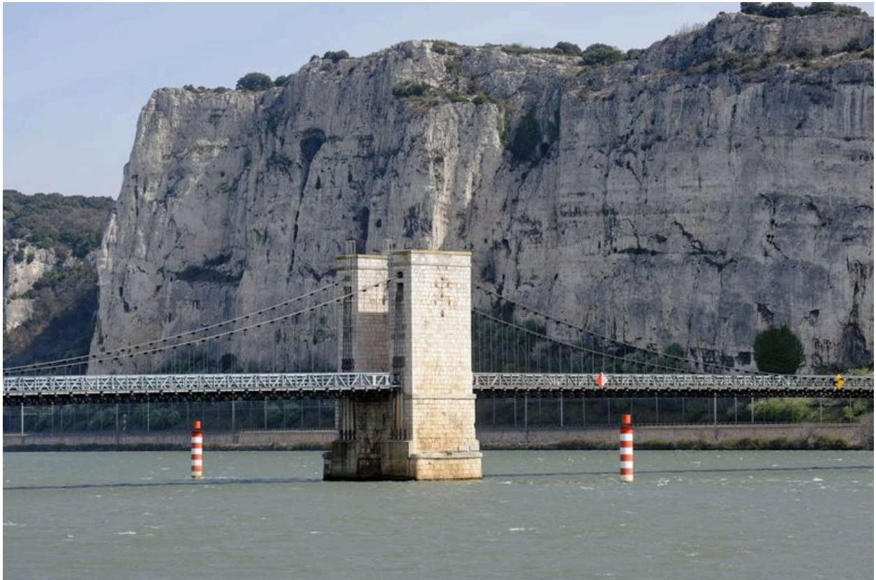
Vue d'un pylône et tablier du pont
