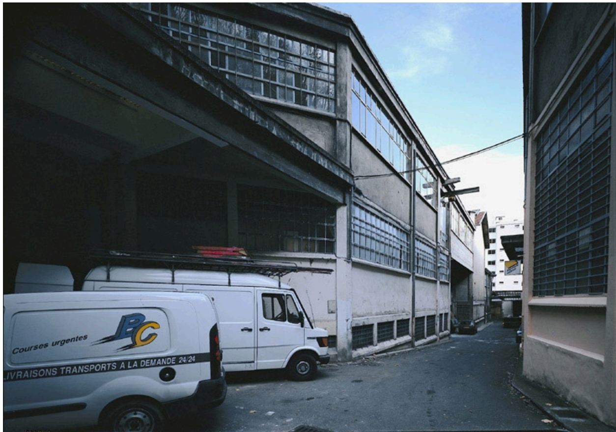
Passage interne du site
