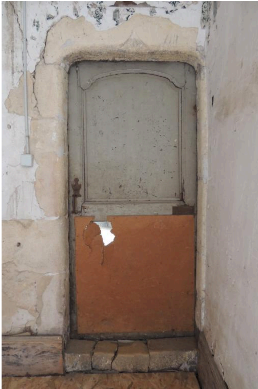
Porte de communication, linteau orné d'une accolade.
