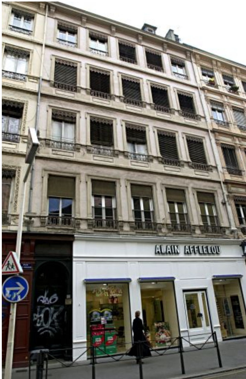
Façade principale, vue générale
