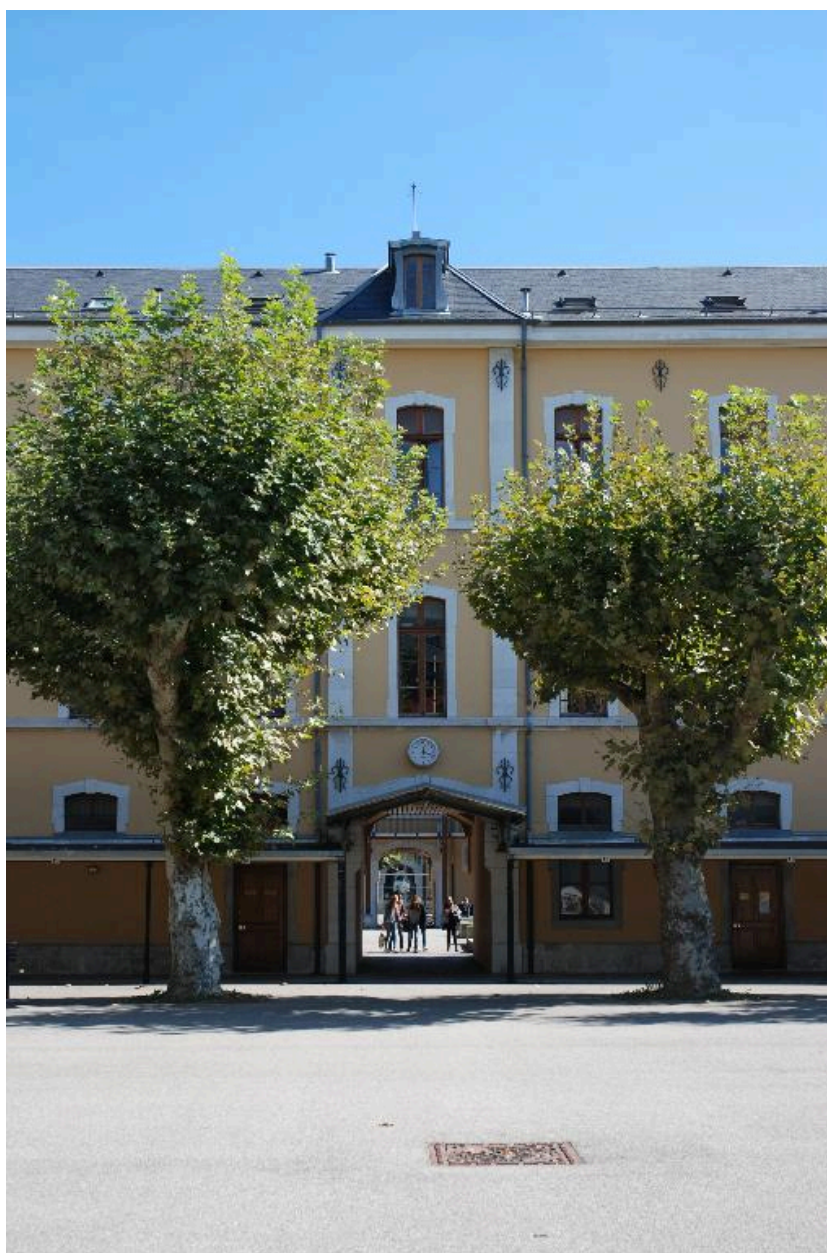
Cour 3 : détail de la travée centrale de l'élévation est
