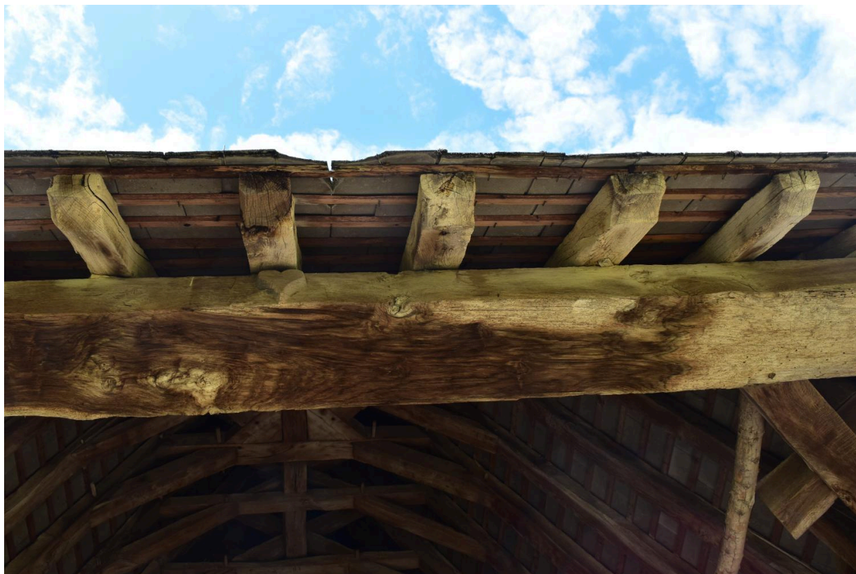
Charpente du auvent de la grange n°1 : détail de motif de cœur, taillé.
