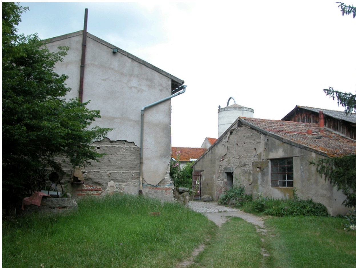
Entrée sud-ouest de la cour, entre le mur pignon du logis et le fournil.
