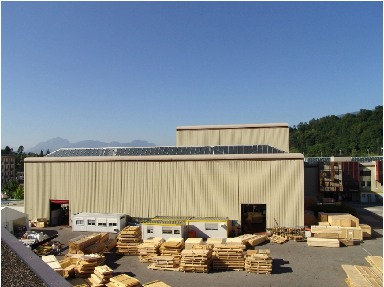
Elévation nord et sheds des ateliers de fabrication BHT1
