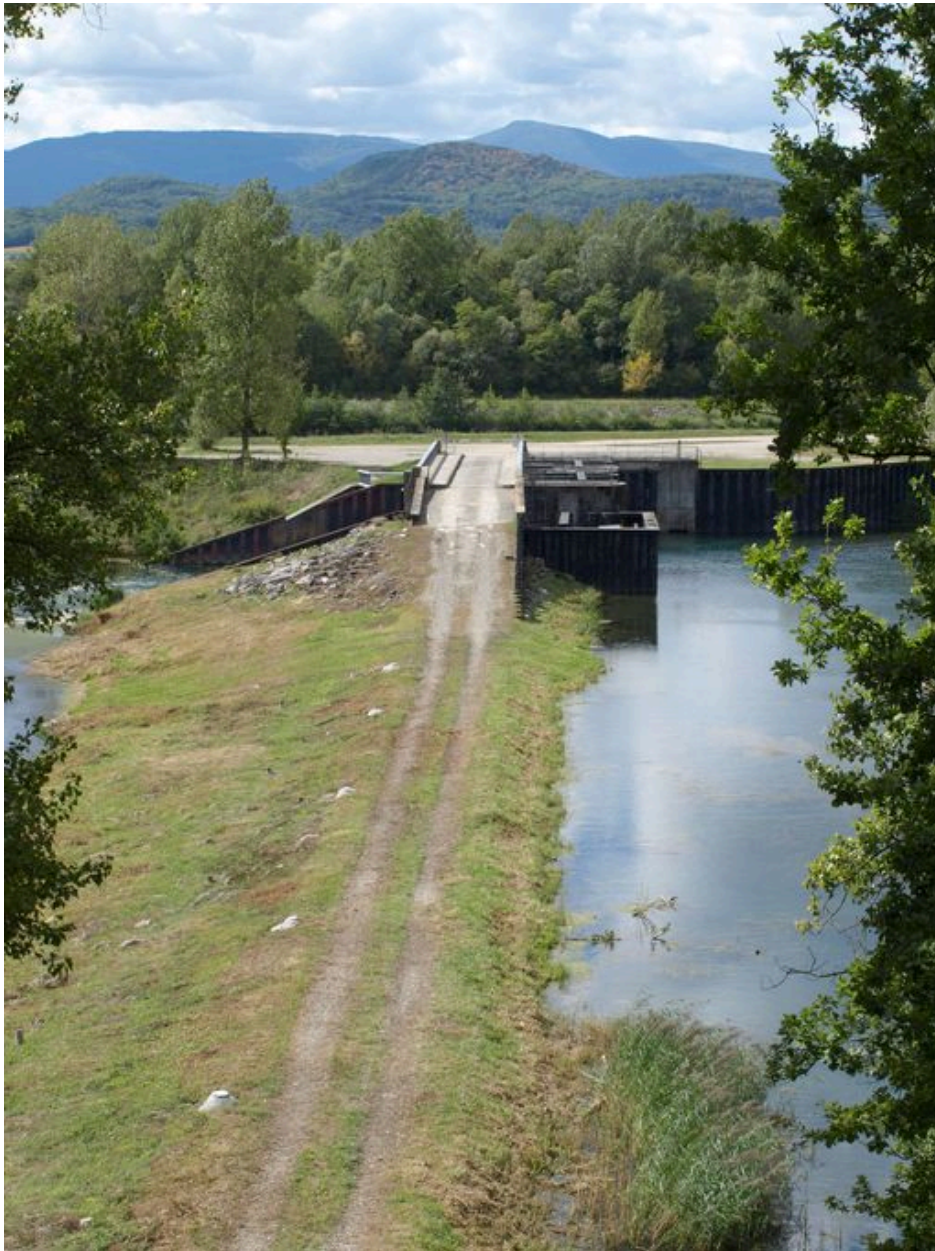
Pont, vue générale
