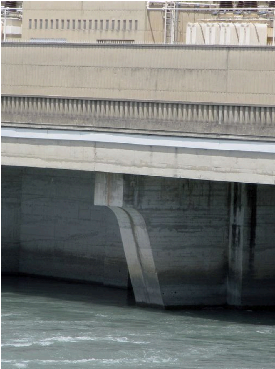
Pont routier, vue partielle : détail d'une pile et du tablier, face aval (depuis la rive gauche)
