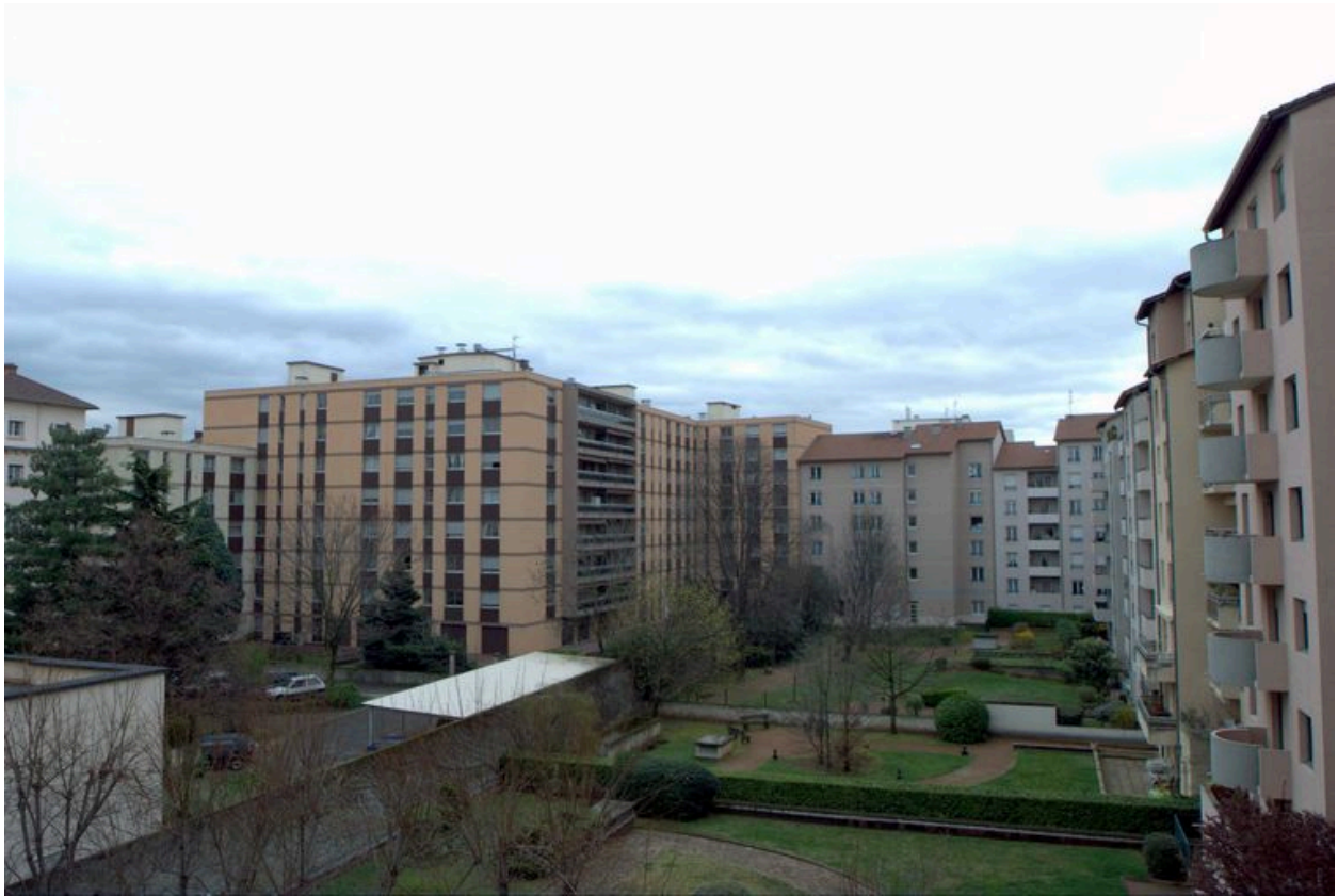
Elévations postérieures, depuis le nord
