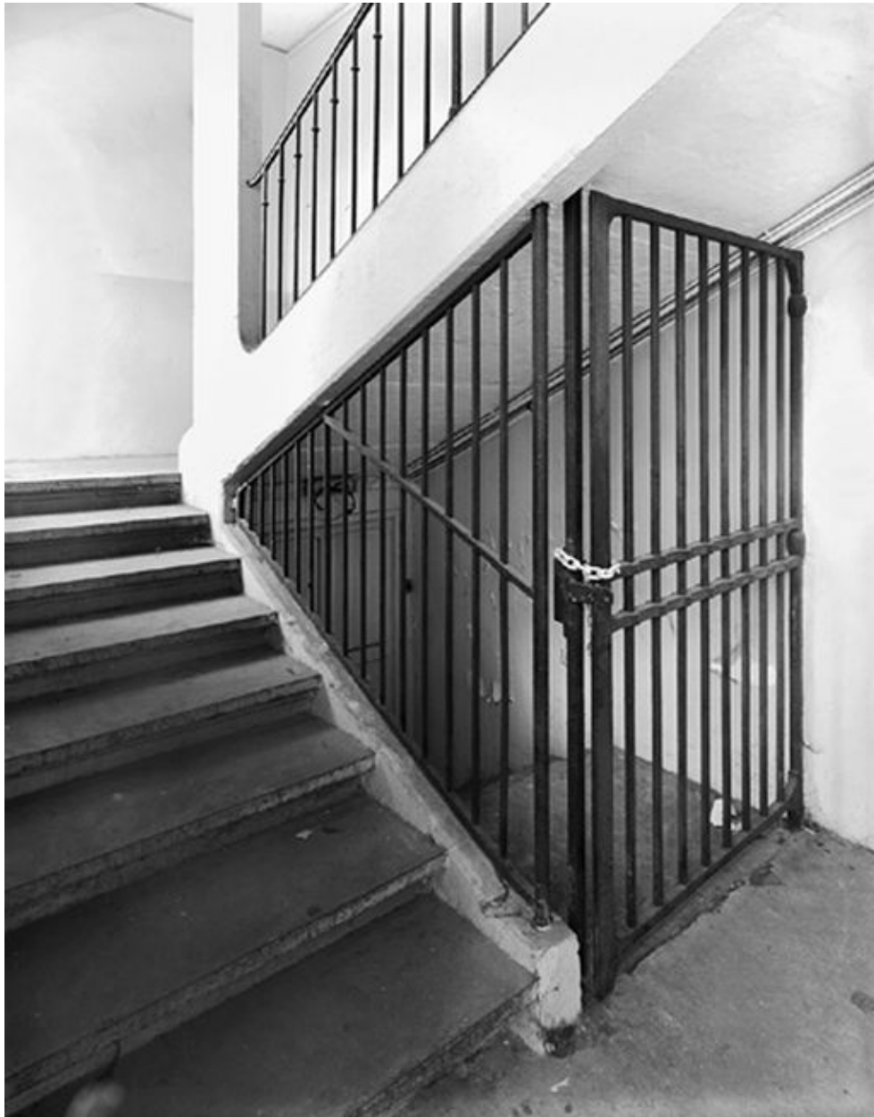
Escalier du corps de liaison nord-ouest, vu depuis le rez-de-chaussée
