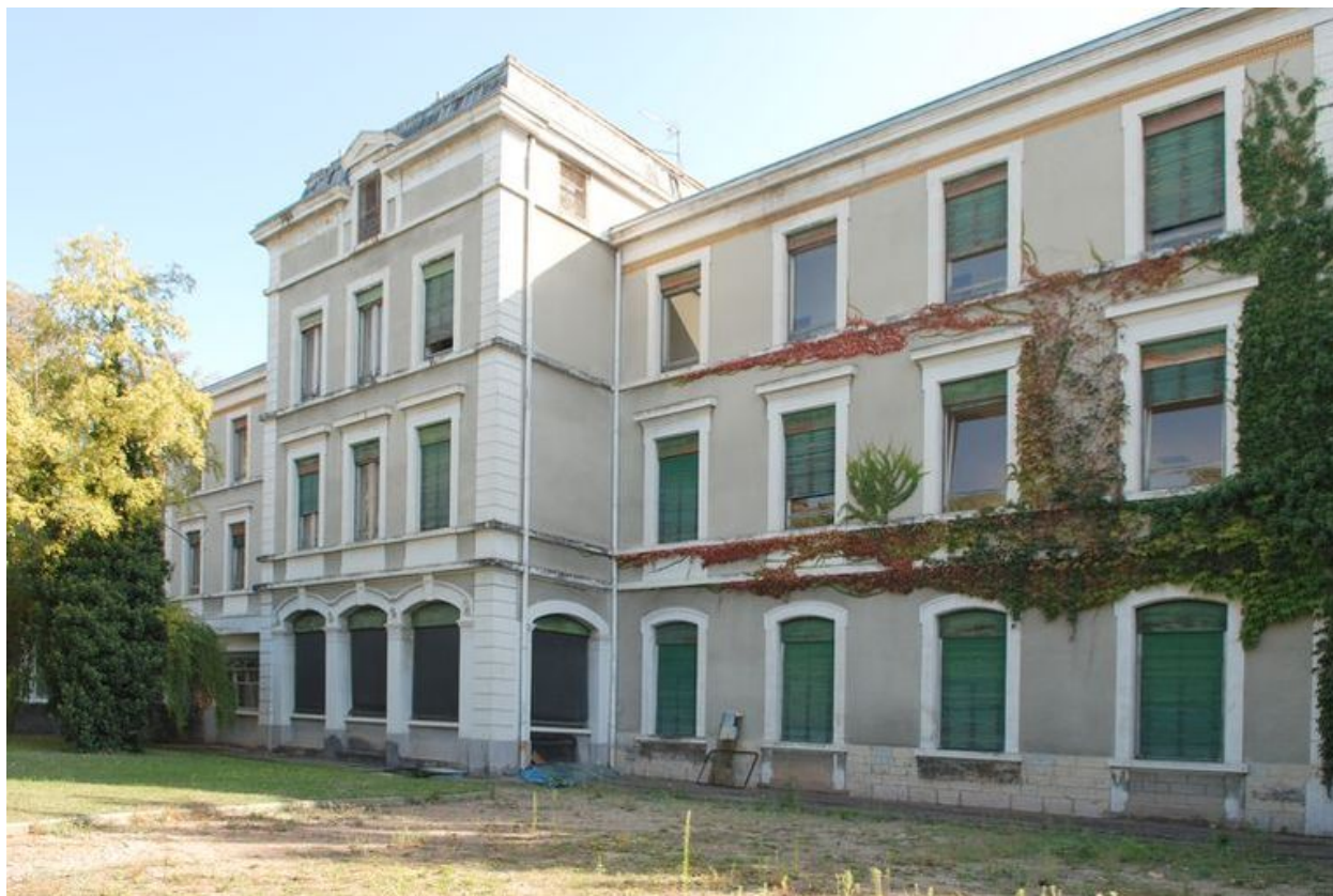
Façade postérieure (ouest) du bâtiment 504
