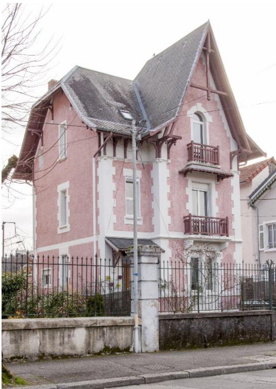
Façade principale (nord) et pignon est
