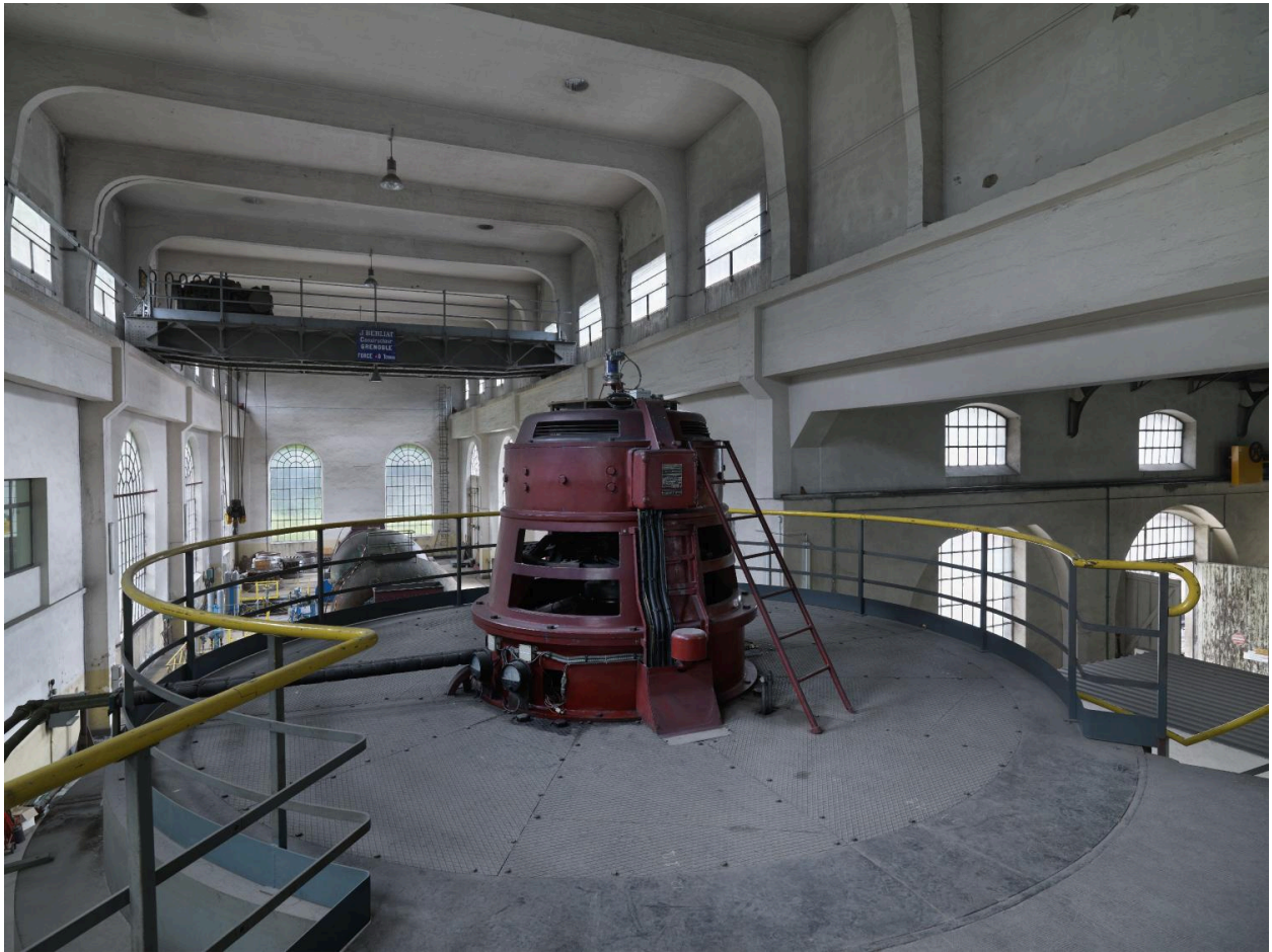
Détail Tête d'exitation du G3 (haut du groupe vertical)
