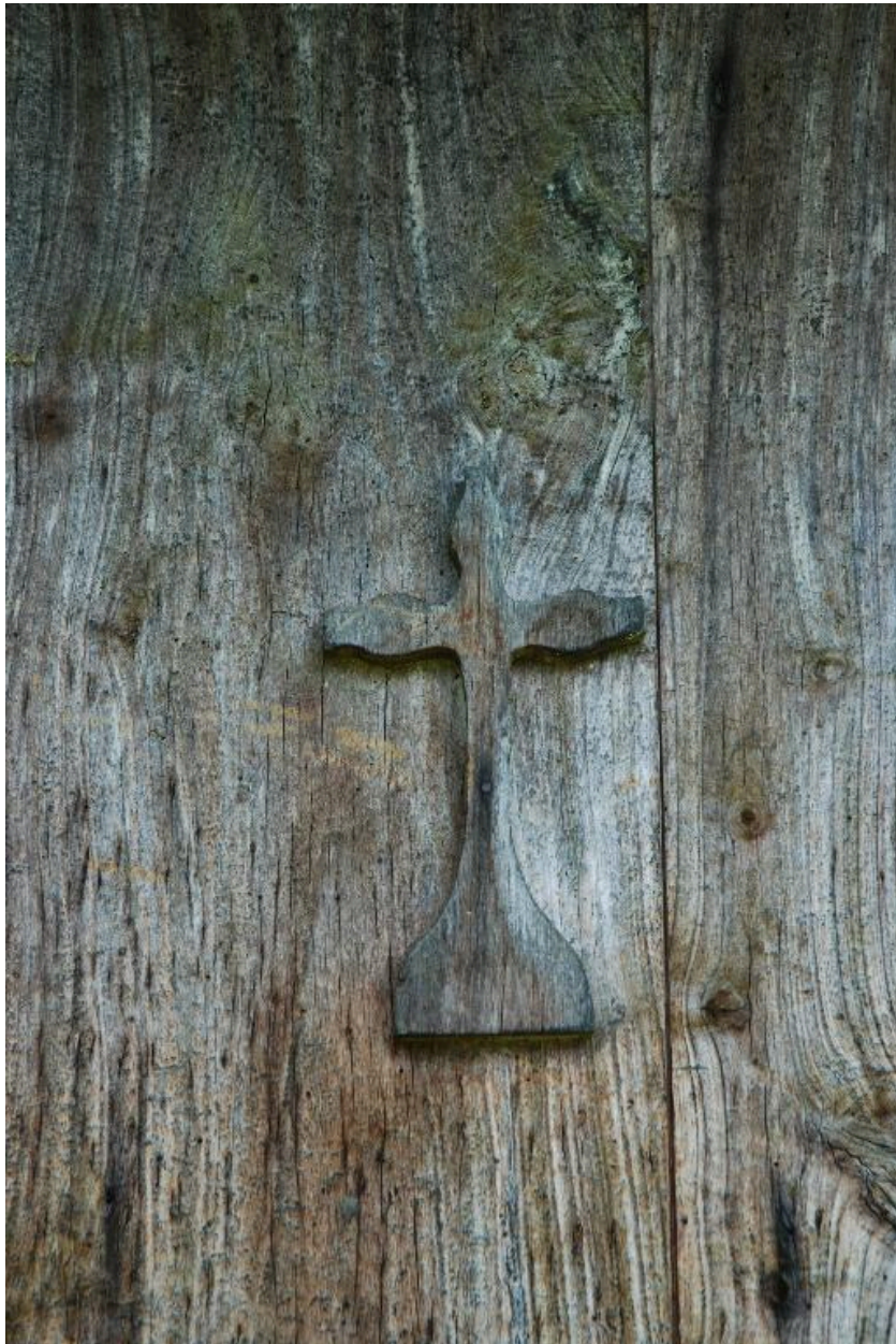
Détail de la porte de la grange : croisette.
