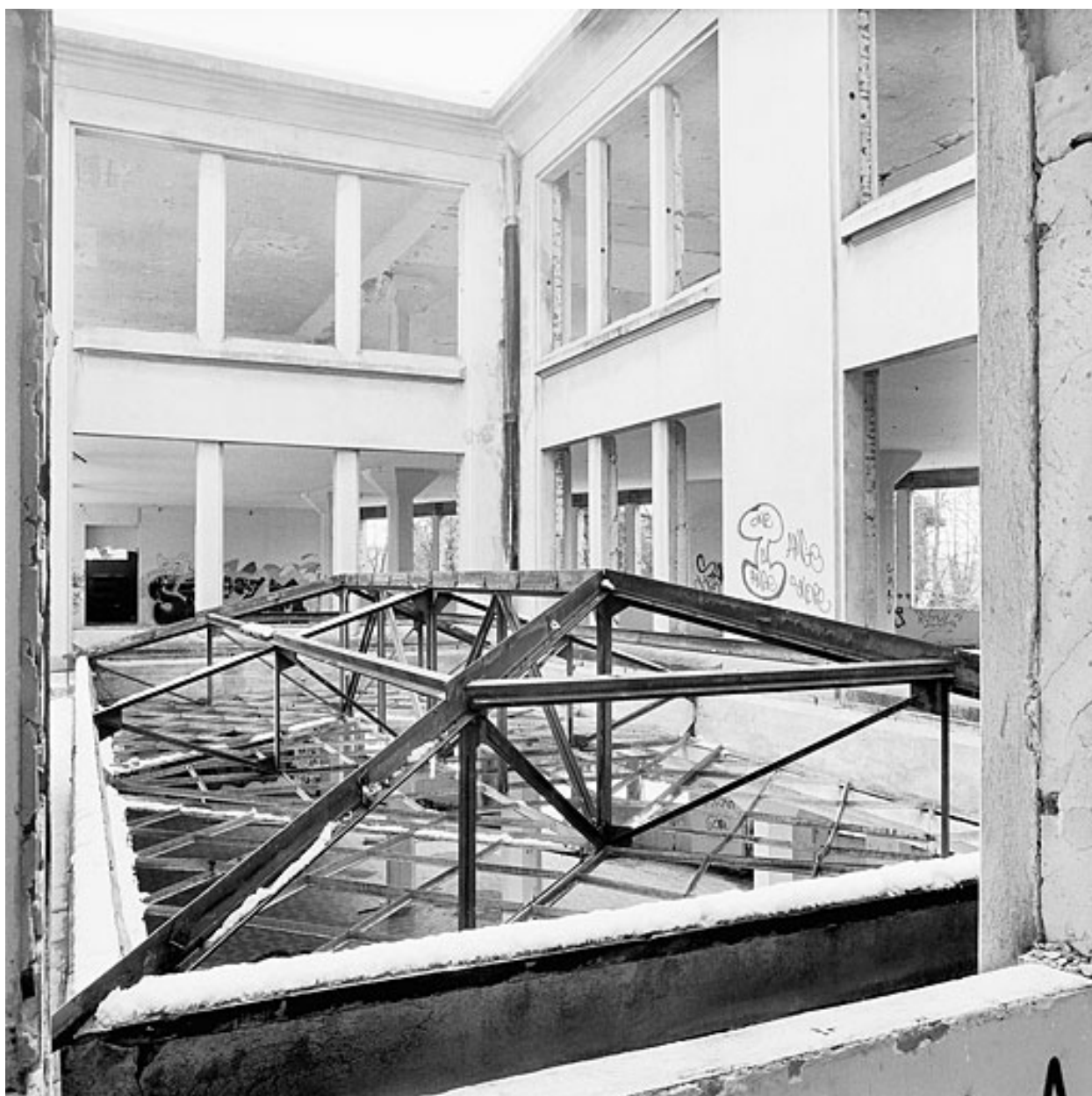
Structure métallique de la verrière
