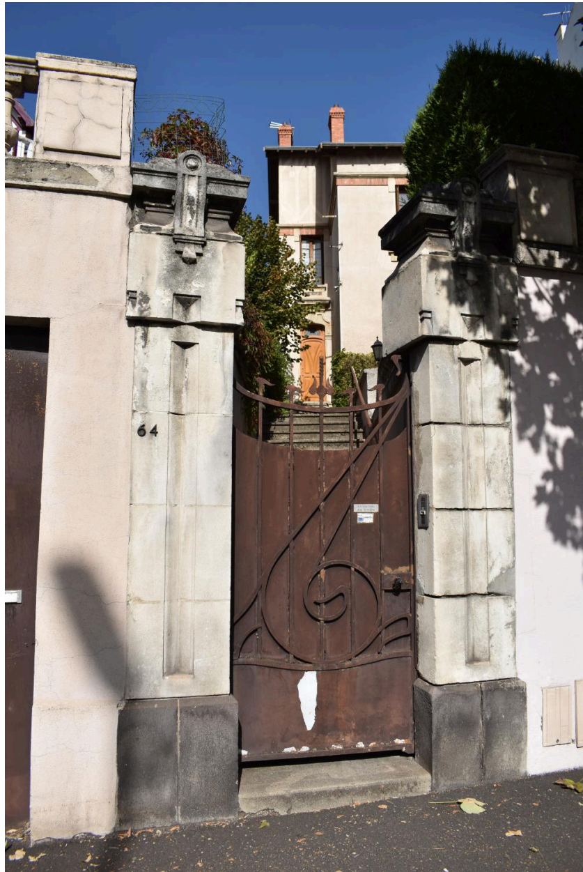
Porte piétonne sans couverture à piliers en pierre de taille
