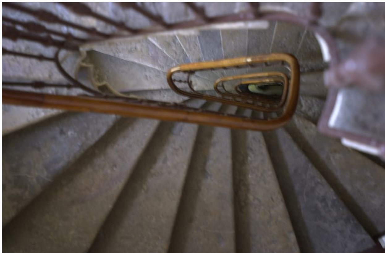
Vue générale de la cage d'escalier
