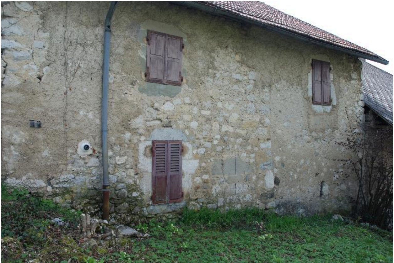
Détail de l'élévation postérieure.
