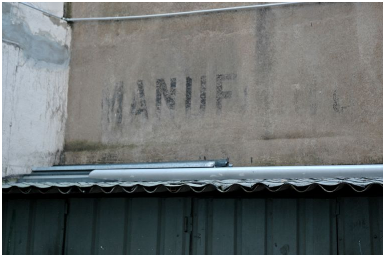
Détail d'inscription peinte en façade sur cour, rappelant la manufacture de vêtements
