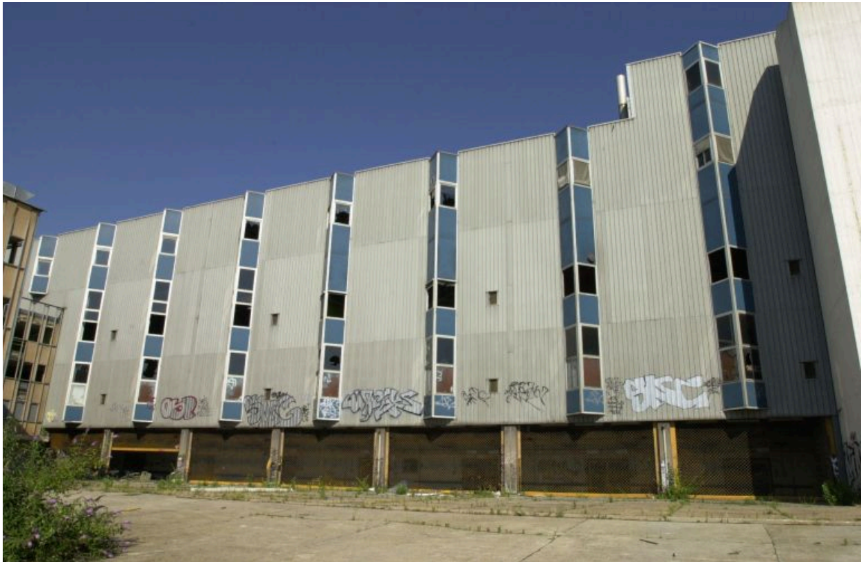
Vue du bâtiment ouest, depuis l'est
