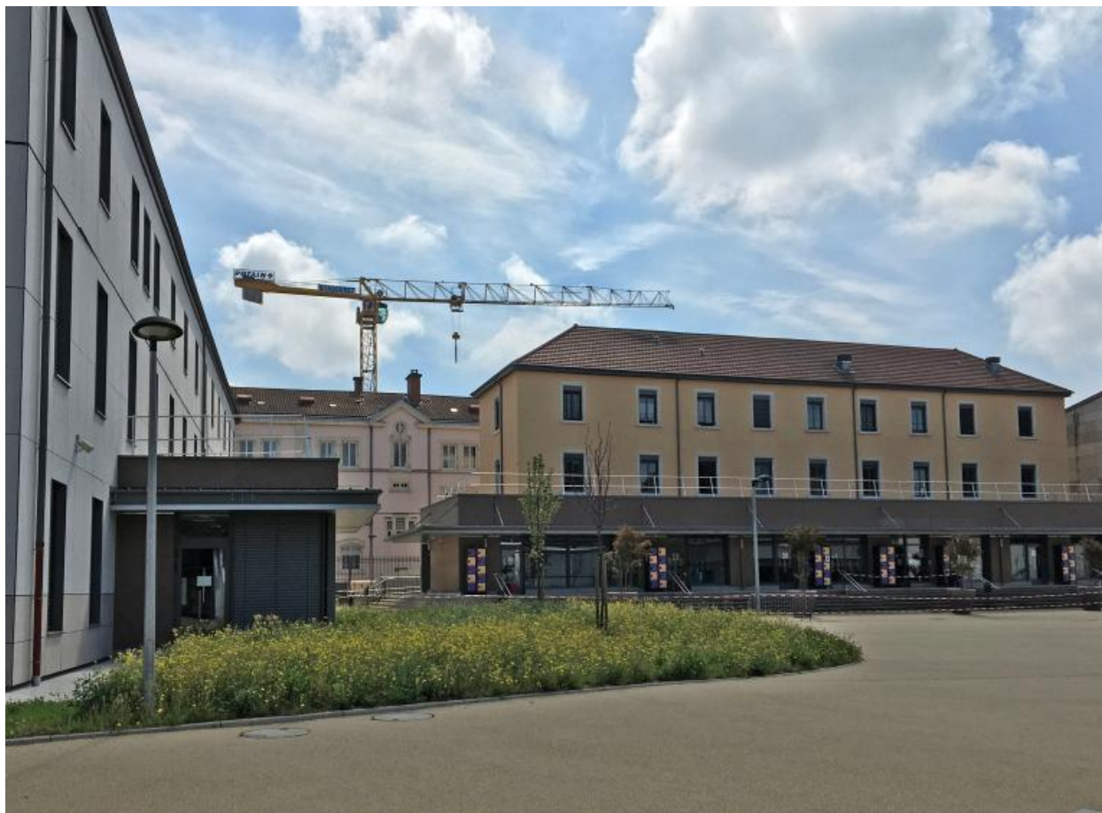
Petit lycée : élévation postérieure
