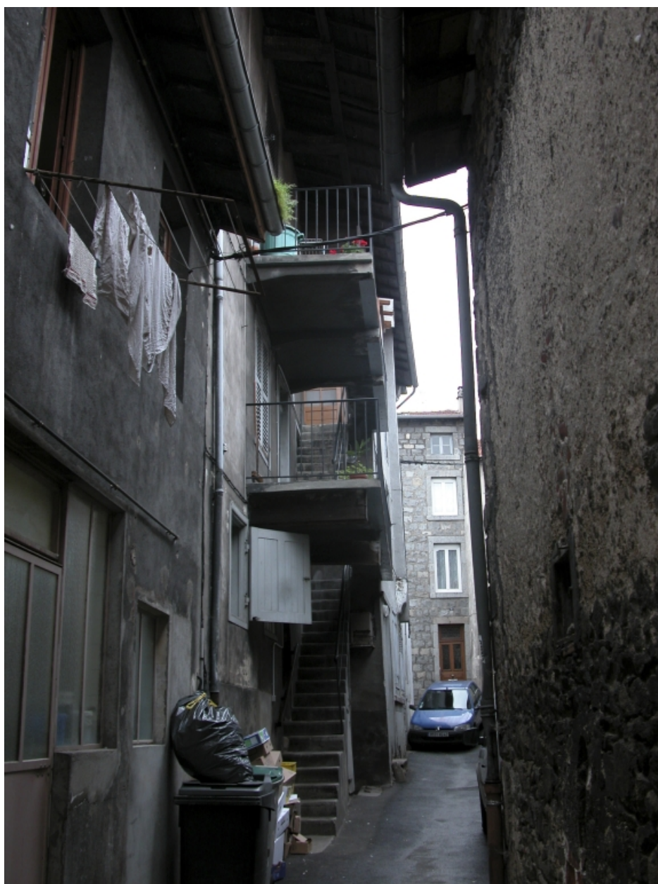
Îlot 2. Roanne (rue de) 03. Vue d'ensemble de la montée d'escalier sur cour.
