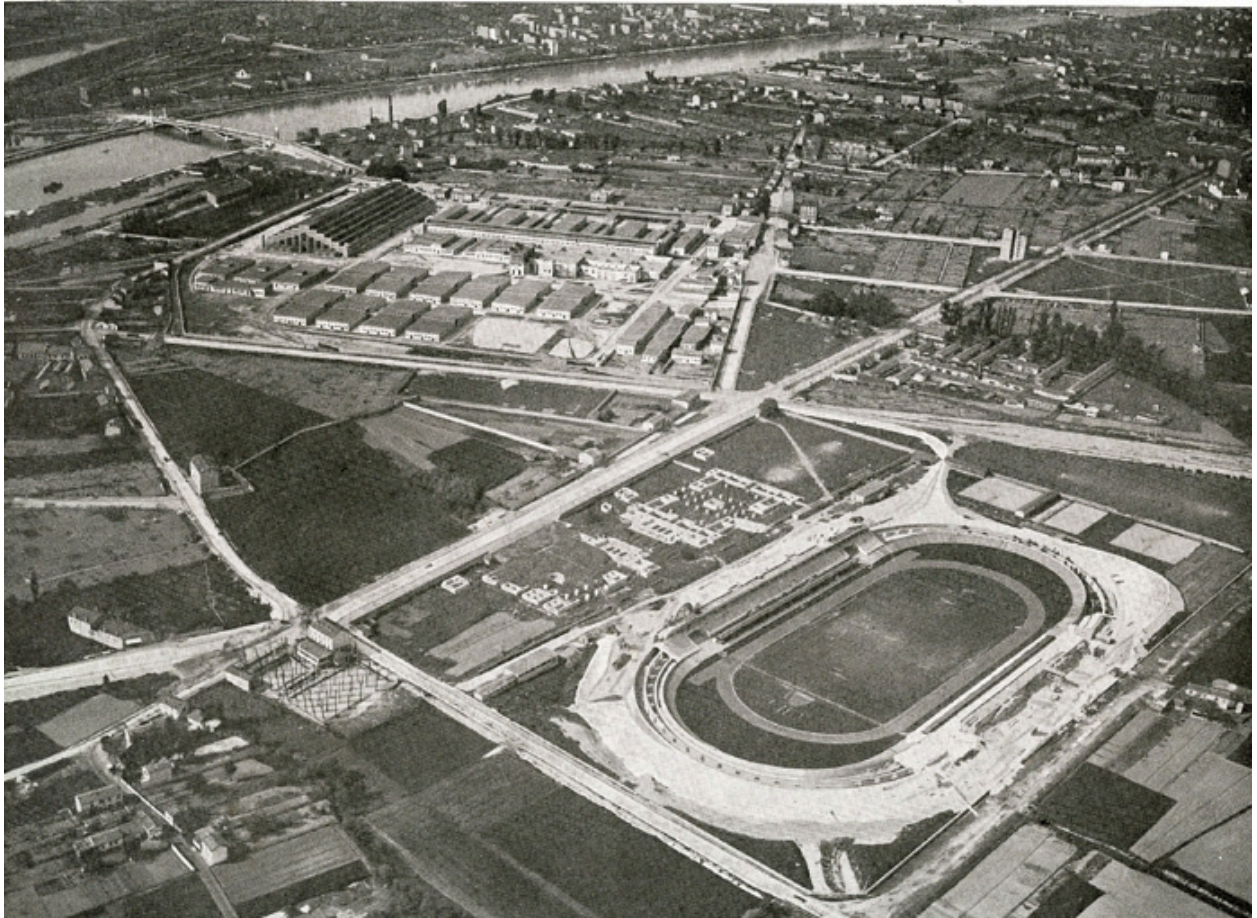
Vue aérienne sud-est des abattoirs de la Mouche en 1920, (phot. Burlaton Georges)
