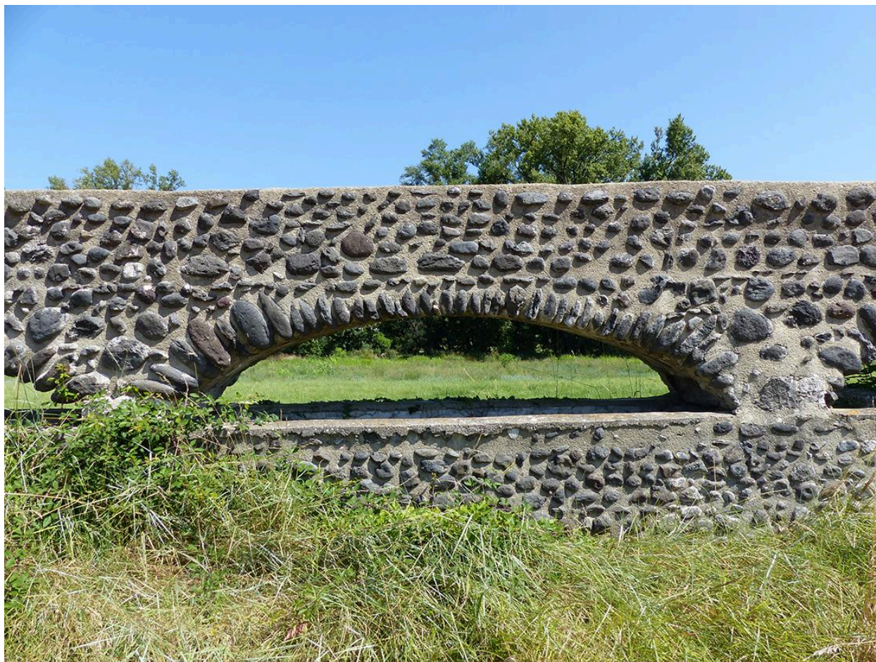
Aqueduc : détail arche maçonnée en galets
